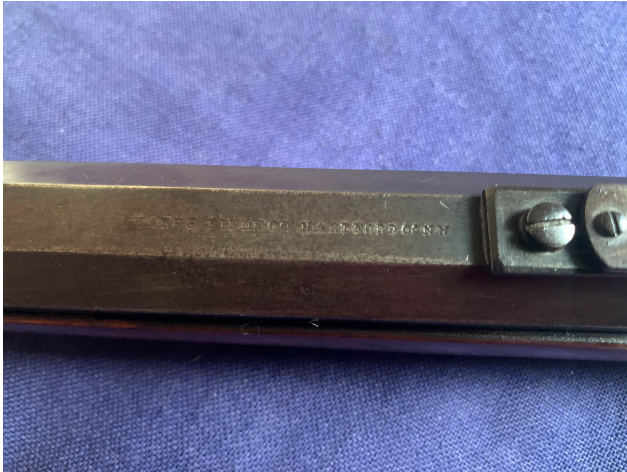
Fig 3 – marquage Sharps sur le canon
